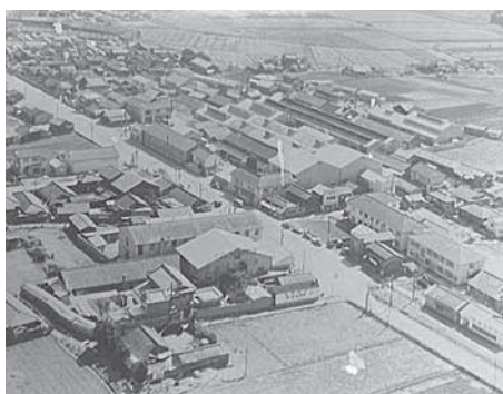
S35年3月3日撮影 鈴江農機製作所付近。 写真左下の横長の建物が旧郵便局。 道路挟んで写真右側が鈴江農機製作所。 現在はサンシャインカルディアになっている。 鈴江さん宅所蔵。
